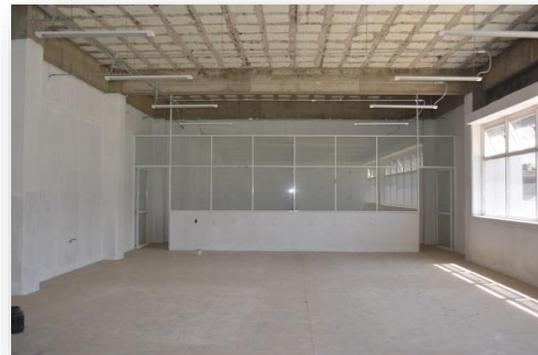
Se colocó piso de cerámica de 60x60 cm. en planta baja del laboratorio, como se muestra en las imágenes. Cubriendo un total aproximado en planta baja de 1150 metros cuadrados.
