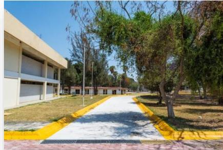
Remodelación de estacionamiento No. 3 el cual tiene el ingreso por acceso 4, se realizaron machuelos, gasa de ingreso con empedrado ecológico, colocación de adoquín en área de cajones, 3 Rampas para personas discapacitadas, y gasa de salida con concreto hidráulico.
